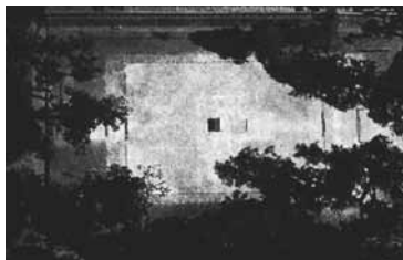
遷宮後の敷地 terrain de l'absence
