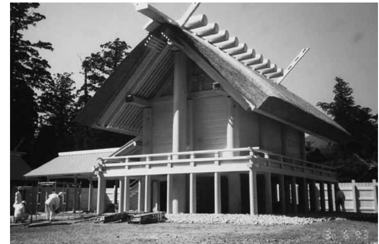
造営中の内宮本殿（現在の本殿） Bâtiment principal de Naigu sous construction (actuel bâtiment)
