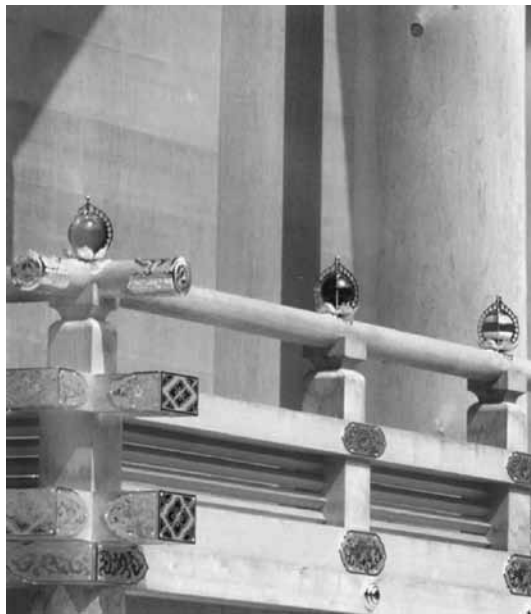
内宮正殿の高欄の据玉 detail de Naigu
